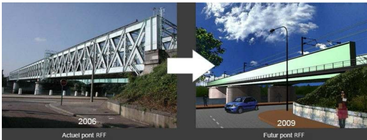
Exemple de changement de pont métallique à Oissel (Seine Maritime)
