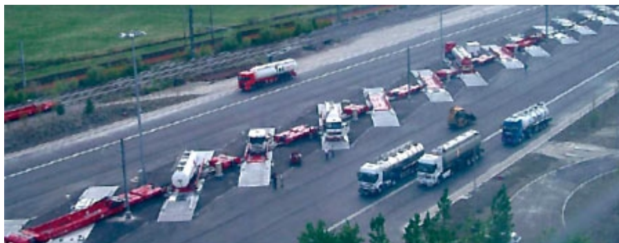
Plate-forme Modahlor à Aiton-Bourgneuf (73)
