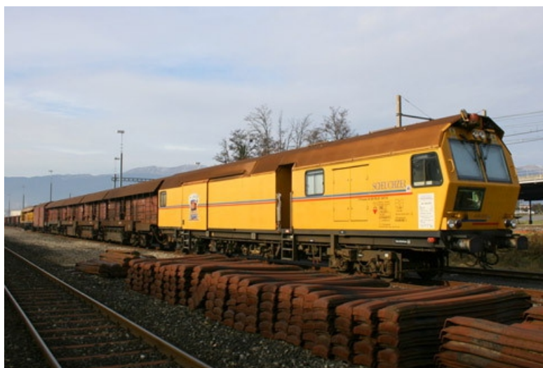
Train meuleur de rails (Scheuchzer S.A.)
