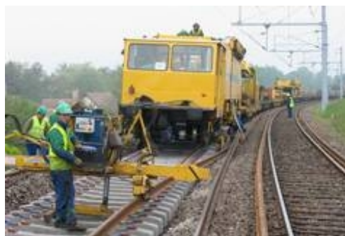
Longs rails soudés sur traverses béton
